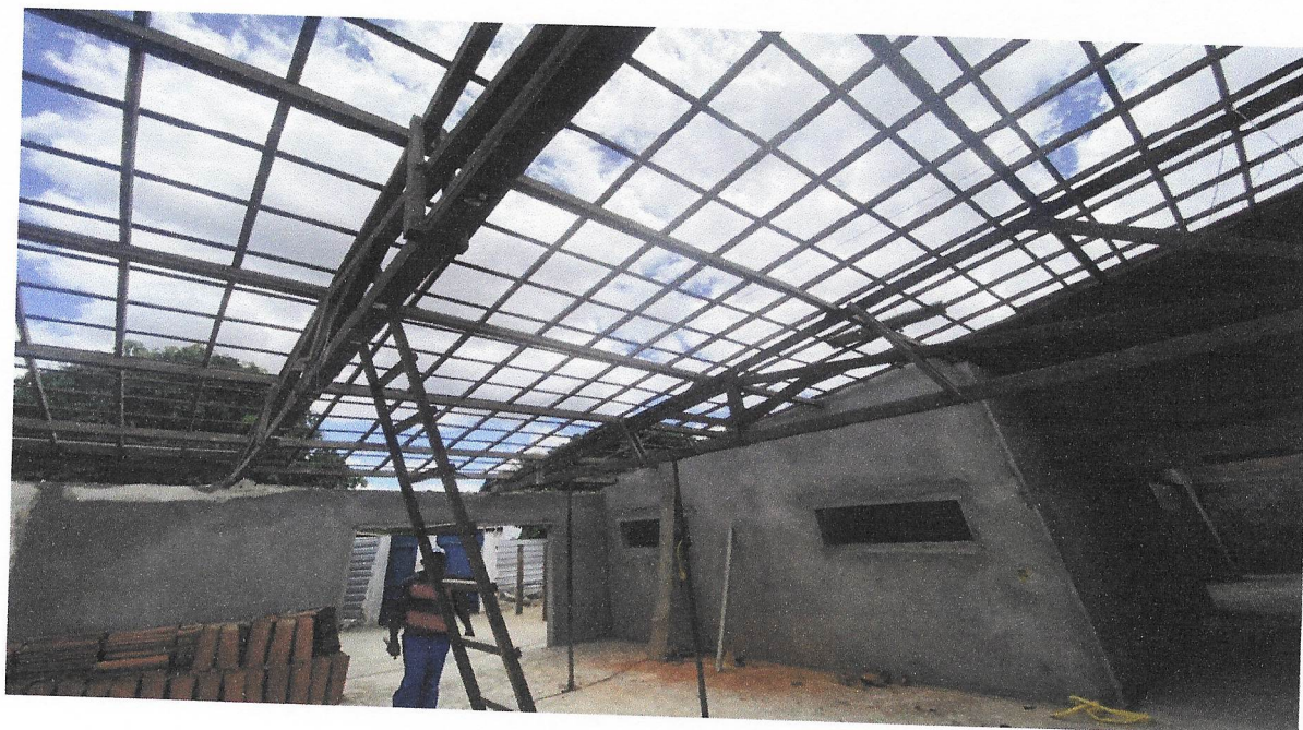
Foto 10 – Revisão em cobertura com telha cerâmica tipo canal comum, Itabaiana ou similar, com reposição de 20% do material
