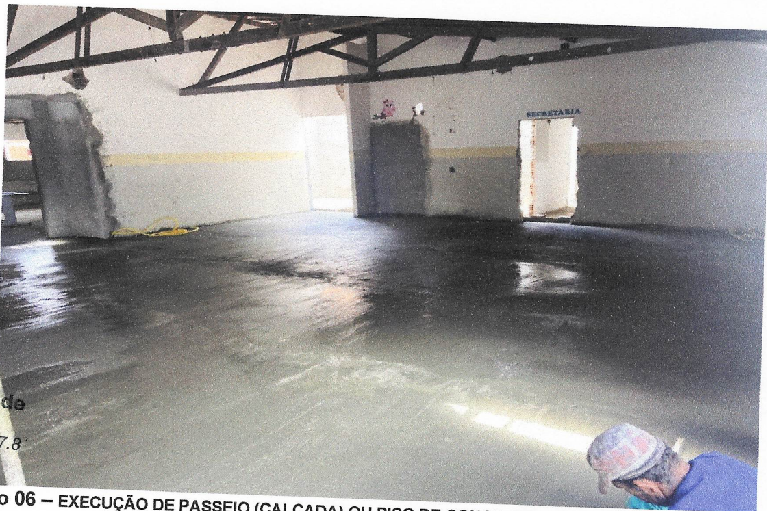
Foto 05 – EXECUÇÃO DE PASSEIO (CALÇADA) OU PISO DE CONCRETO COM CONCRETO MOLDADO IN LOCO
