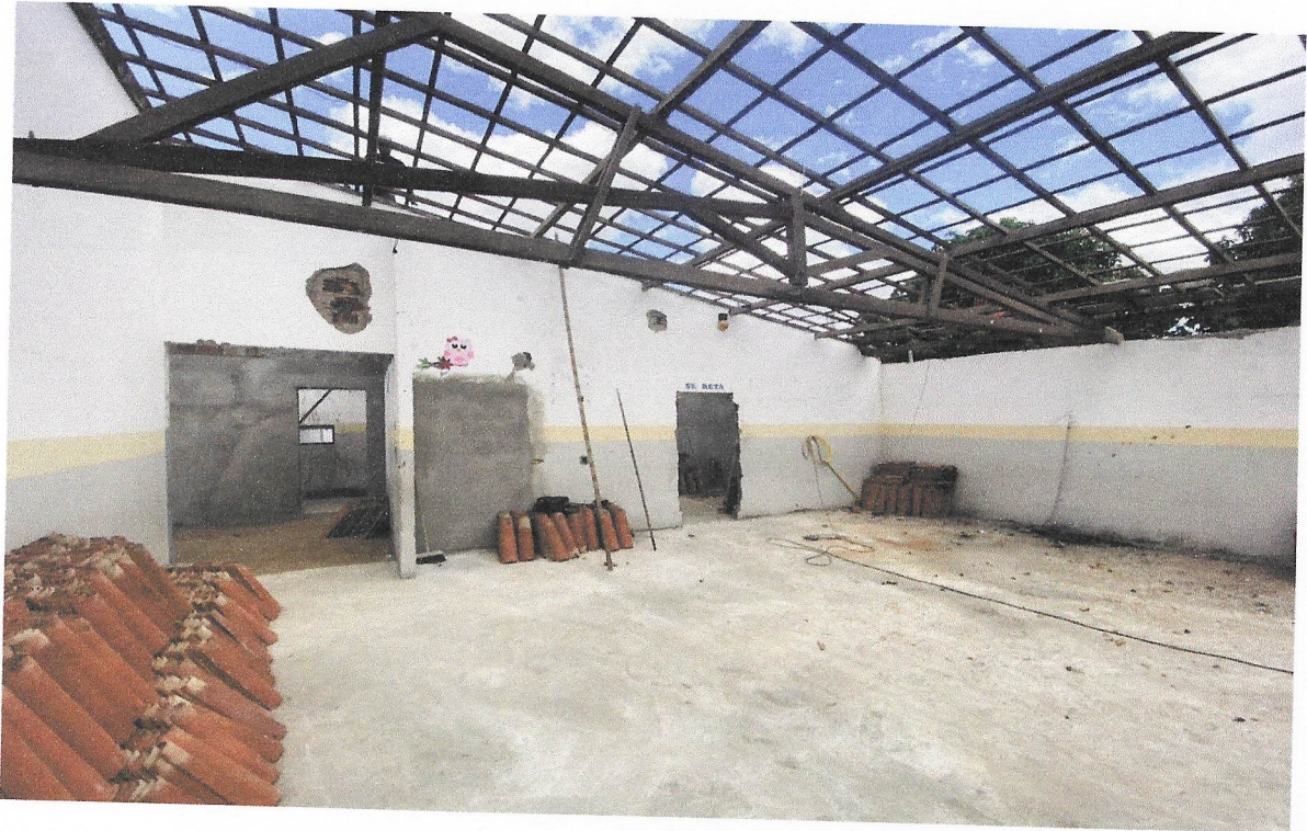
Foto 11 -- Revisão em cobertura com telha cerâmica tipo canal comum, Itabaiana ou similar, com reposição de 20% do material
