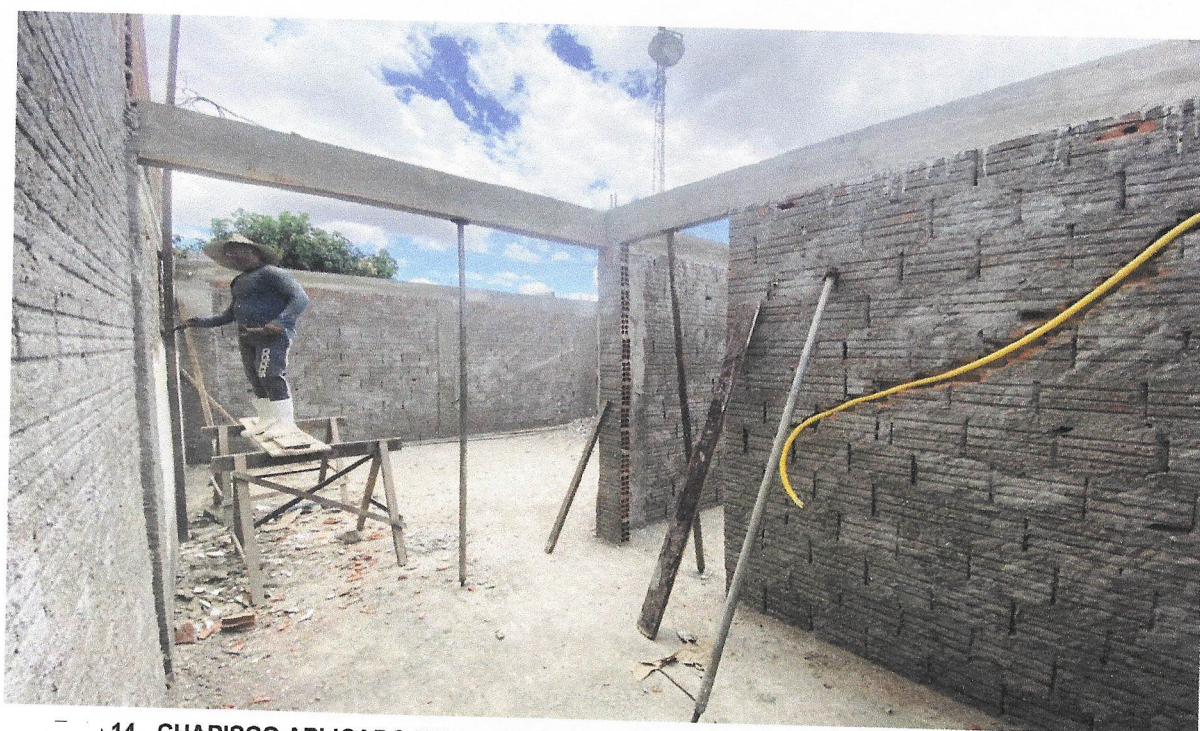
Foto 14 - CHAPISCO APLICADO EM ALVENARIA (COM PRESENÇA DE VÃOS) E ESTRUTURAS DE CONCRETO
