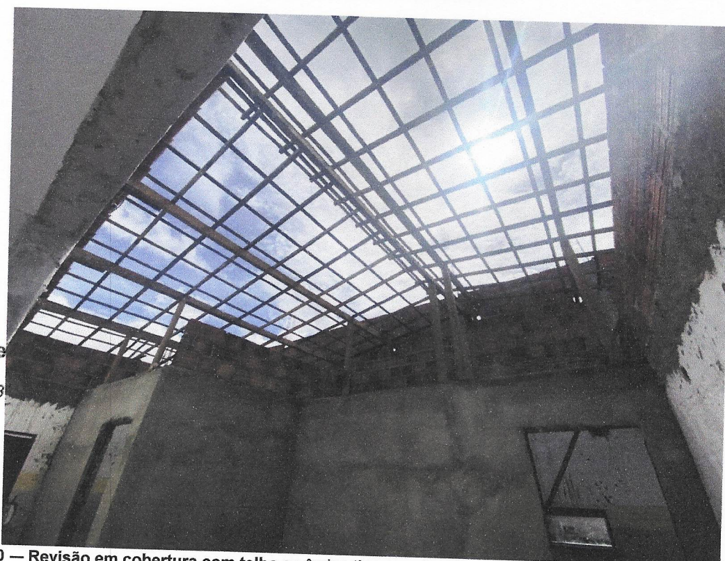
Foto 19 -- Revisão em cobertura com telha cerâmica tipo canal comum, Itabaiana ou similar, com reposição de 20% do material
