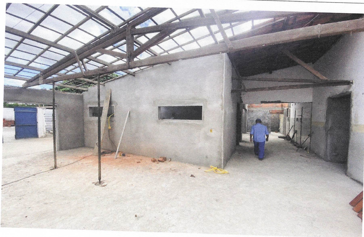
Foto 09 – Revisão em cobertura com telha cerâmica tipo canal comum, Itabaiana ou similar, com reposição de 20% do material.
