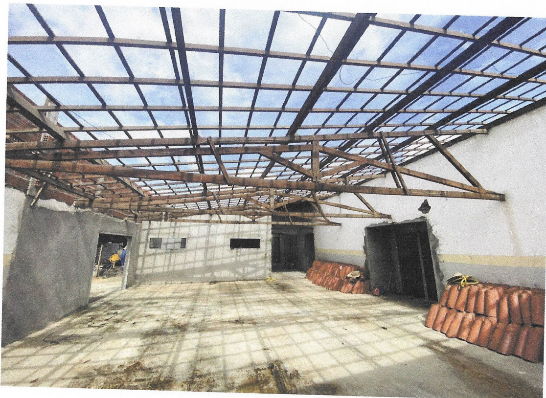
Foto 19 -- Revisão em cobertura com telha cerâmica tipo canal comum, Itabaiana ou similar, com reposição de 20% do material
