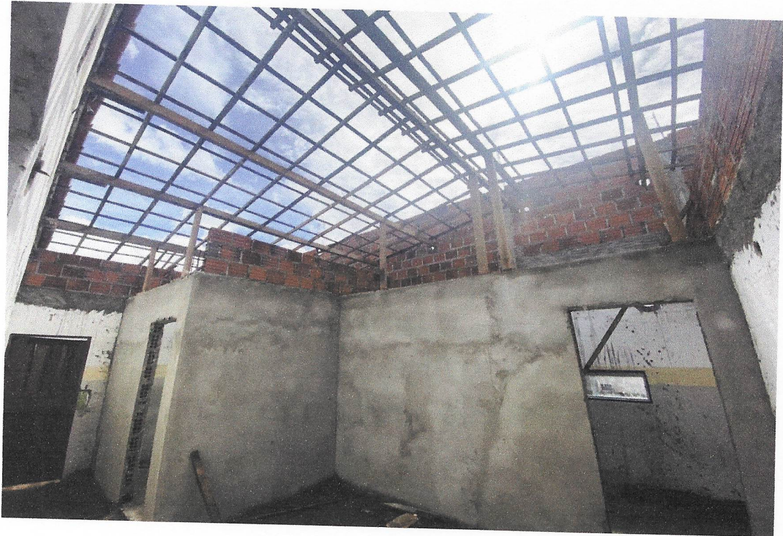
Foto 21 - - Revisão em cobertura com telha cerâmica tipo canal comum, Itabaiana ou similar, com reposição de 20% do material.
